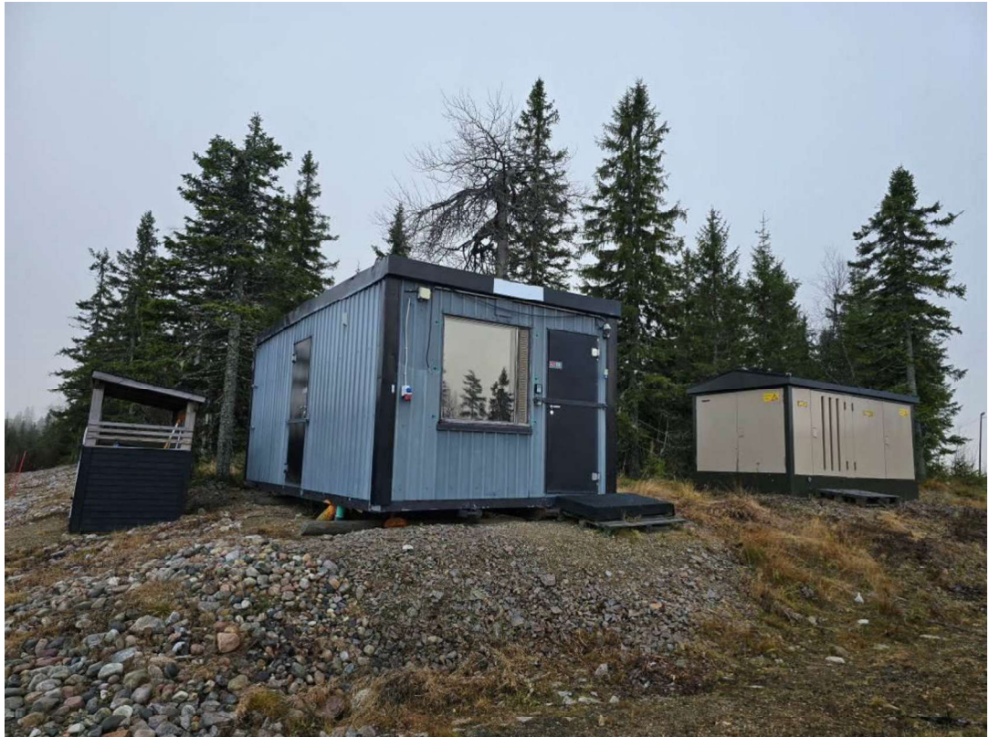
Kuva 9 Teknisen huollon tila ja puistomuuntaja
