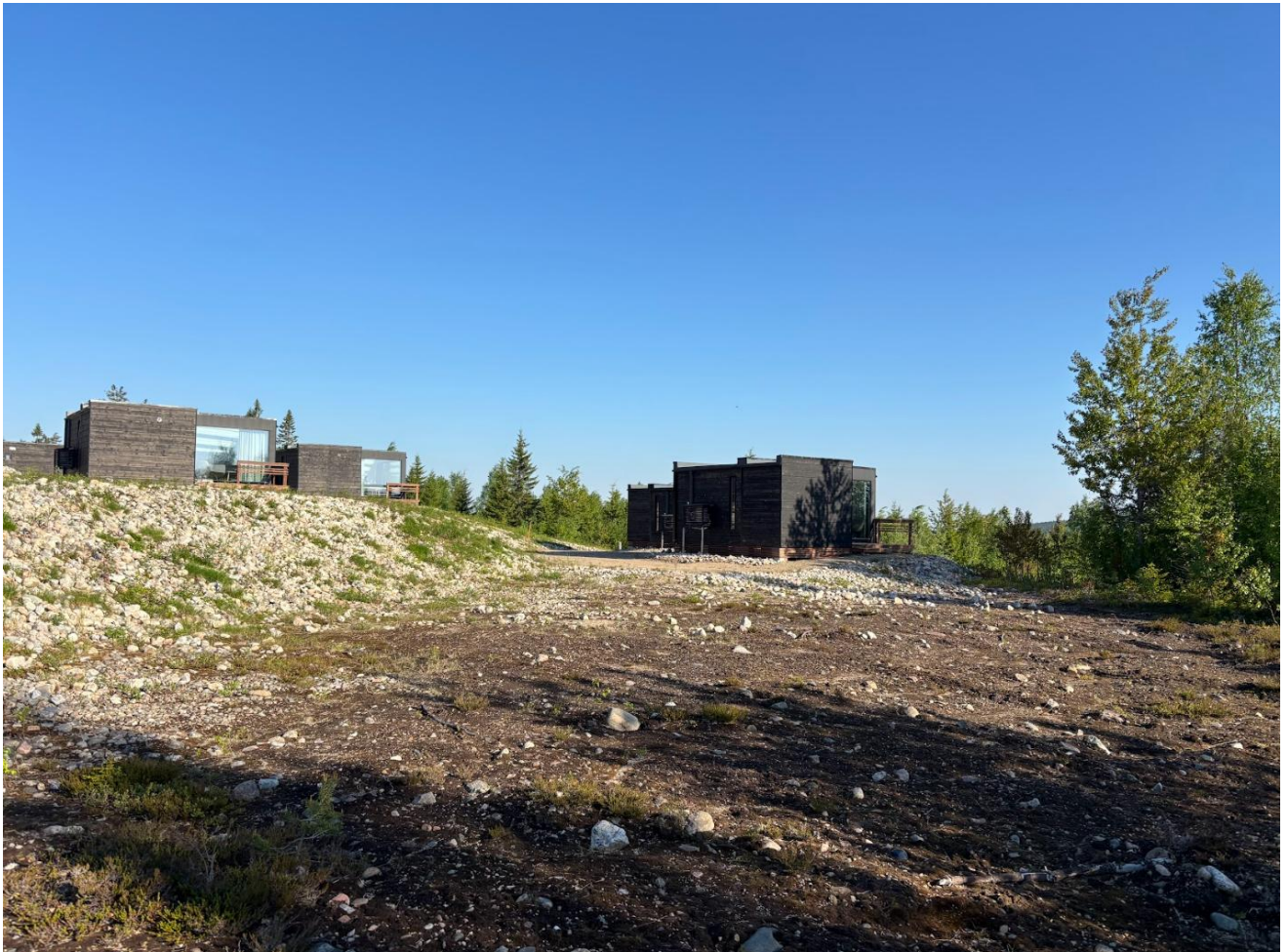
Kuva 5. Olemassa olevia rakennuksia
